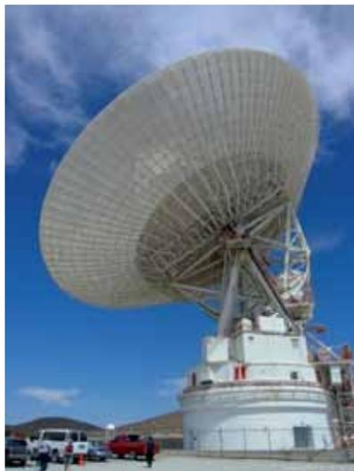
**Рис. 1.12.** Бистатистическая РЛС «Голдстоун», передающая и приемная антенны
